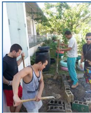
El Capítulo Gamma ayudó en la reparación del estacionamiento del Centro de Impedidos de San Germán.
